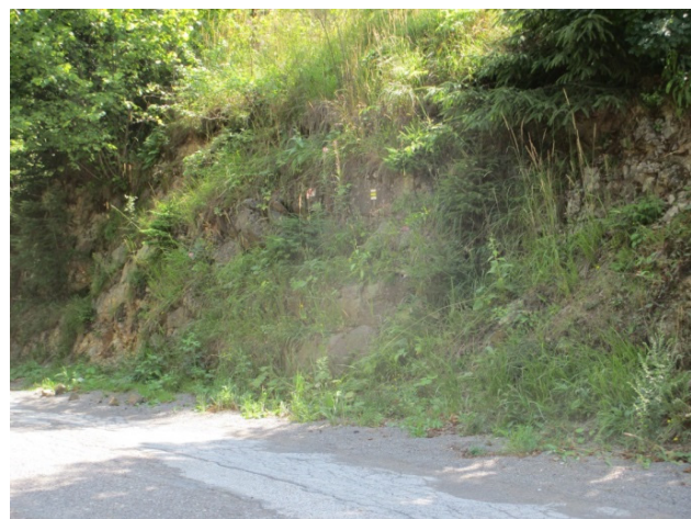
zemný zráz popri asfaltovej ceste
