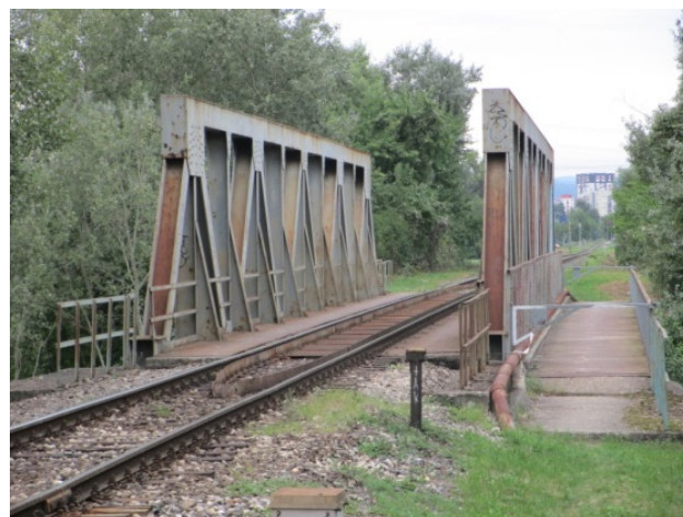
železničný most & mostík pre peších ponad rieku
